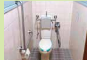
車いす対応トイレ
